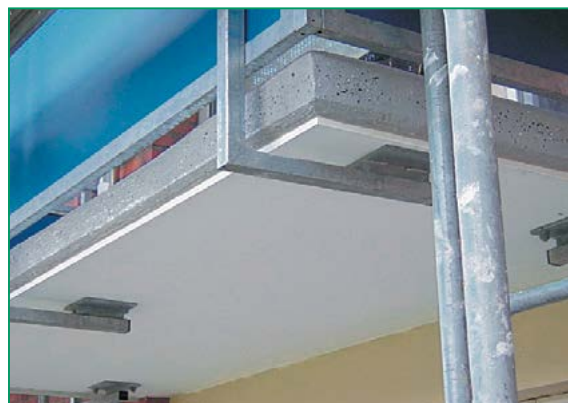
Od spodu: VESTEROL® MS 55 HSP, -SF 10A – zaprawa naprawcza, szpachla drobnoziarnista, farba silikatowa
