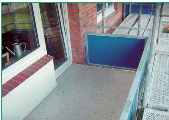
System: HADALAN® PUR – okładzina posadzkowa z dodatkiem kolorowych płatków
